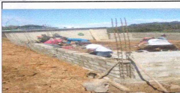
Foto2: Aula 1 avanzando en la colocación de block para la sustitucion de pared
