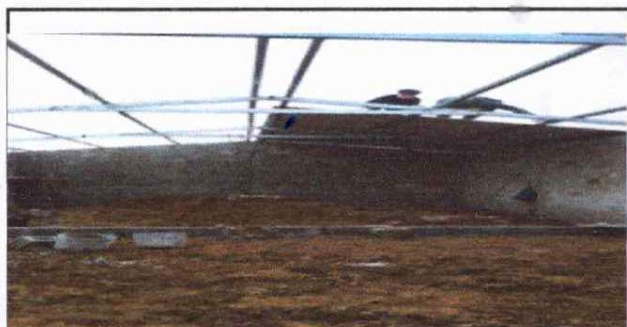
Foto 5. colocacion de costaneras en sustitucion de las vigas de madera.
