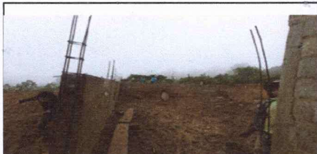
Foto 3: avnce de colocacion de block sustitucion de pared
