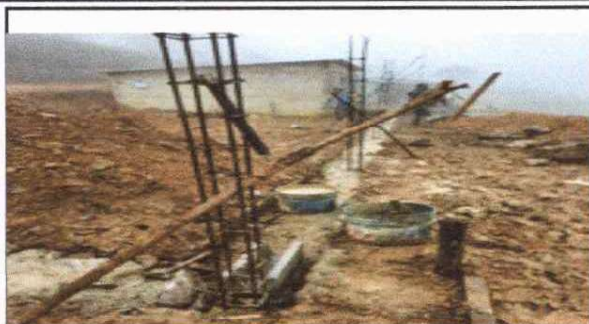
Foto1: Así dio a inicio la sustitucion de las paredes de las aulas
