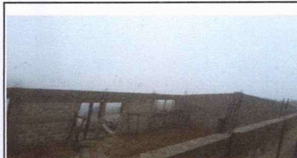
Foto 4: paredes de sustitucion terminada.
